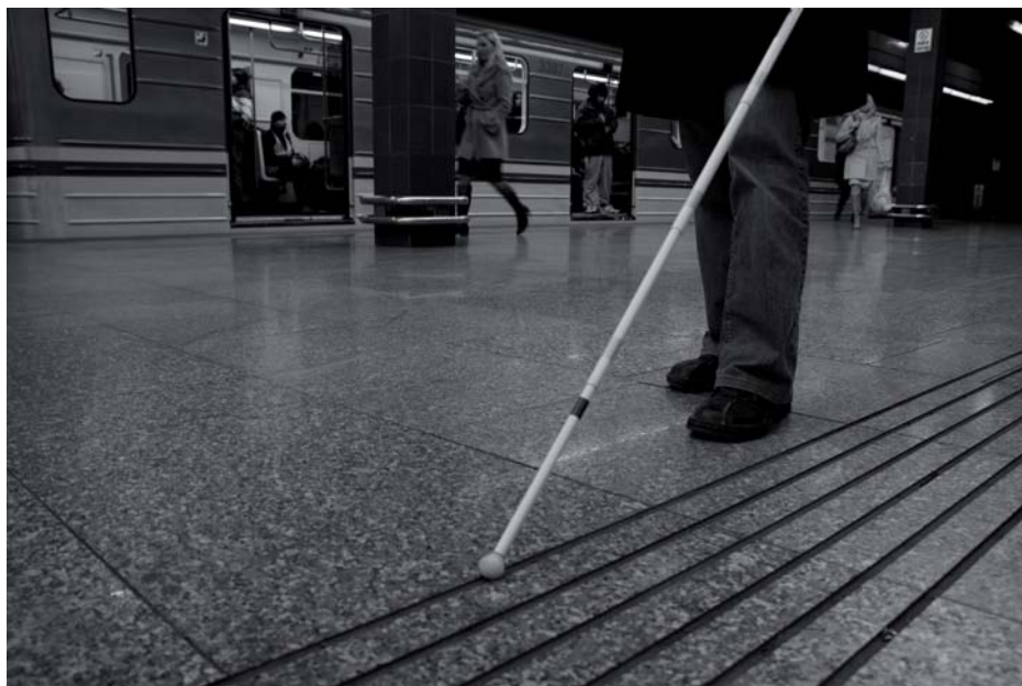
Obr. 9: Využití vodicích linií na nástupišti metra
